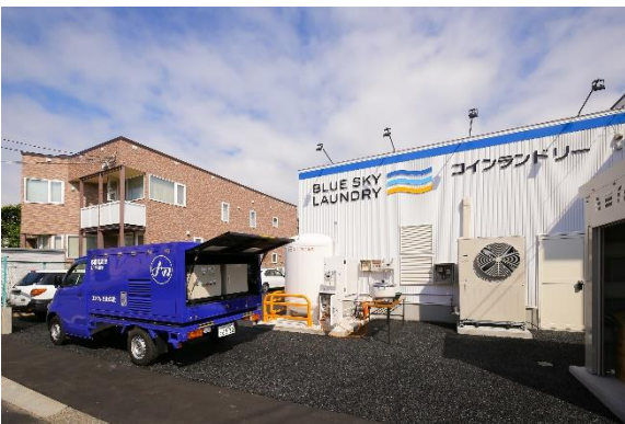
LP ガス仕様移動電源車による発電
